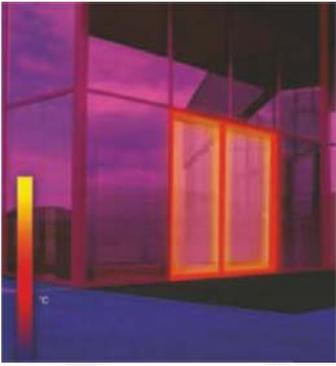
Moderne Fassade - aber Eingang mit konventionellen, nicht wärme- gedämmten Profilen: Unnötiger Energieverlust
